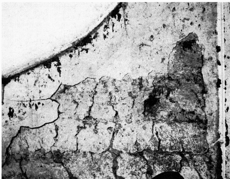
Bild 8. Detalj av innervägg i lerhuset i kvarteret S:t Johannes. Bilden visar hur väggarna byggts upp av fyrkantiga lerstycken och därefter överdragits med puts. Foto 1959.
