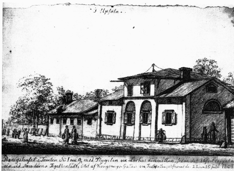
Bild 1. »I Uppsala. Boningshuset i Tomten N o 1 och 9, med Flygelen och Lerhus därimellan, sedan det blifvit rappat och vid Arcaderna Tegelbeklädt, litet af Kongsängs-Gatan och Tullporten; Afteknat 22 och 25 Julii 1805.» Efter svartkristeckning av hovintendent GUSTAF AF SILLÉN. Uppsala universitetsbibliotek. De avritade byggnaderna låg på gården Kungsängsgatan 31, nuvarande kvarteret Gudrun, tomt nr 11 och 12.
