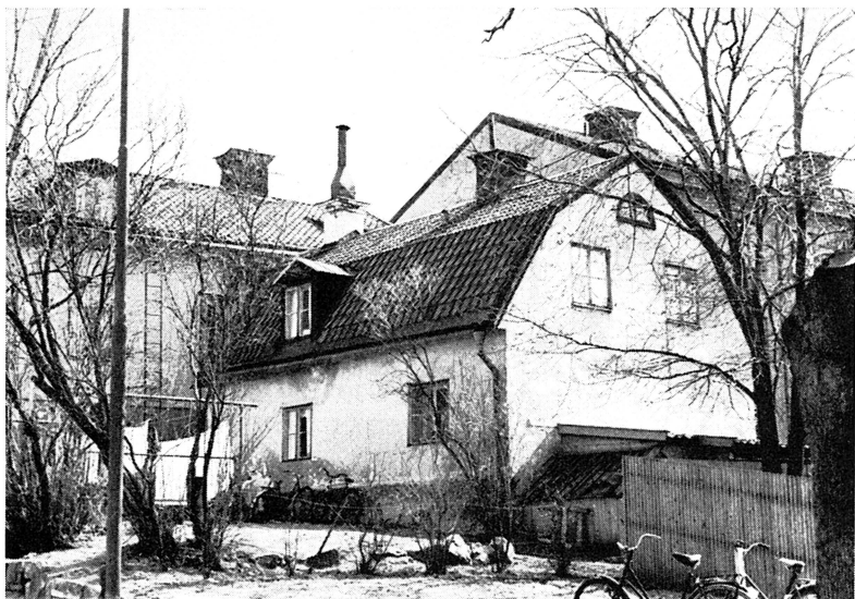
Bild 5. Det 1814 uppförda lerhuset i kvarteret S:t Johannes från norr. Till vänster den tvåvånga träbyggnaden från 1840-talet och i bakgrunden Borgarhemmet från 1839. Foto WOLTER EHN 1959.
