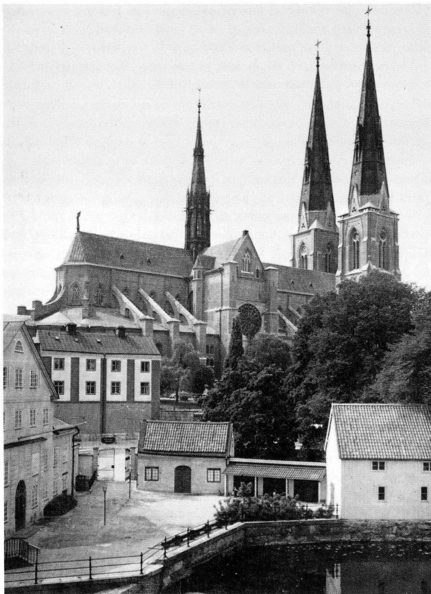
Bild 4. Uppsala domkyrka, dess nordsida, före nu pågående restaurering. De två väststörnen och deras kontakt med långhuskroppen framträder tydligt. Strax till vänster om nordtranseptet ses krönet av det nuvarande brunnshuset över S:t Eriks källa, tidigare betraktad som Trefaldighetskälla. Miljön norr om domkyrkan kan ha föresvävat målaren i Lohärad när han framställde scenen med Kristi dop, bild 3. Foto T. Lindeberg. Återgivet med tillstånd av AB Axel Pettersson & Son, Uppsala.
