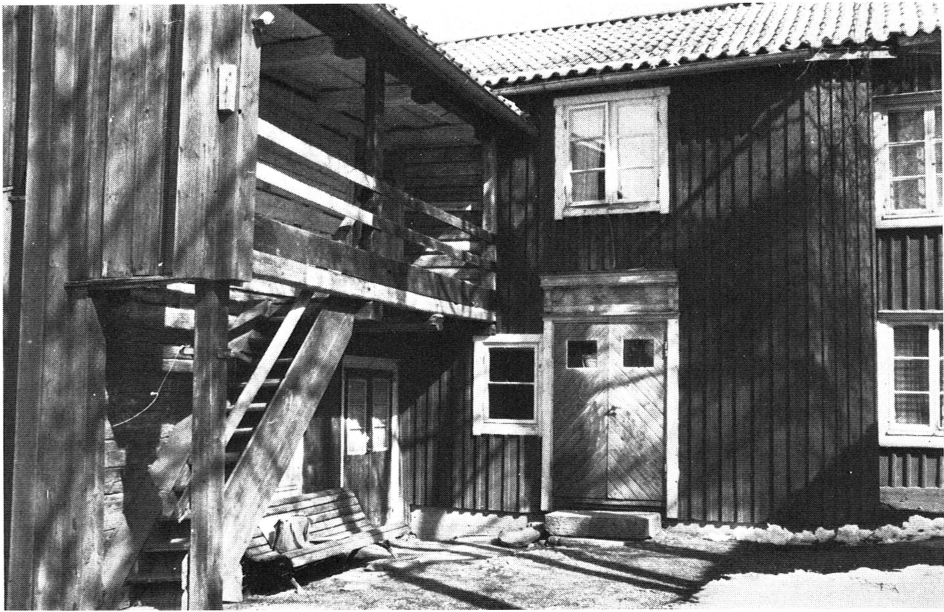
Bild 19. Öregrund. En intressant gårdsinteriör, ett f. d. stadsjordbruk från 1800-talets första hälft insprängt bland rena bostäder. I dag befinner sig tyvärr både byggnader och gård i mycket dåligt skick (kv. Amor 13:5).
