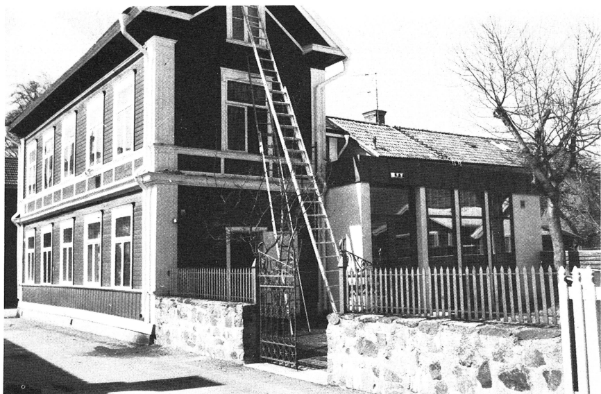
Bild 18. Öregrund. Stadens gamla telegraf från 1890-talet, i dag församlingssal med modern tillbyggd del. I fasaden samverkar i enkel harmoni liggande och stående fasspântpaneler, som tillsammans med listverk, knutar och takfötter skapar en rogivande helhet. Till detaljerna bör man också uppmärksamma järnstaketet med sin jugendinspirerade grind. (kv. Asken 12:5).
