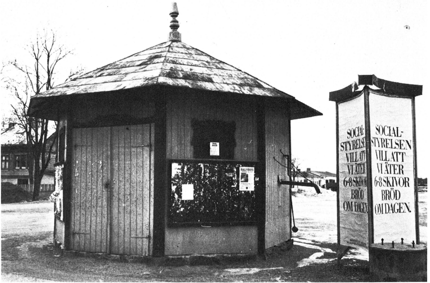
Bild 12. Östhammar. Ett av stadens gamla pumphus från sent 1800-tal (i kv. Rådhuset mot fjärden).
