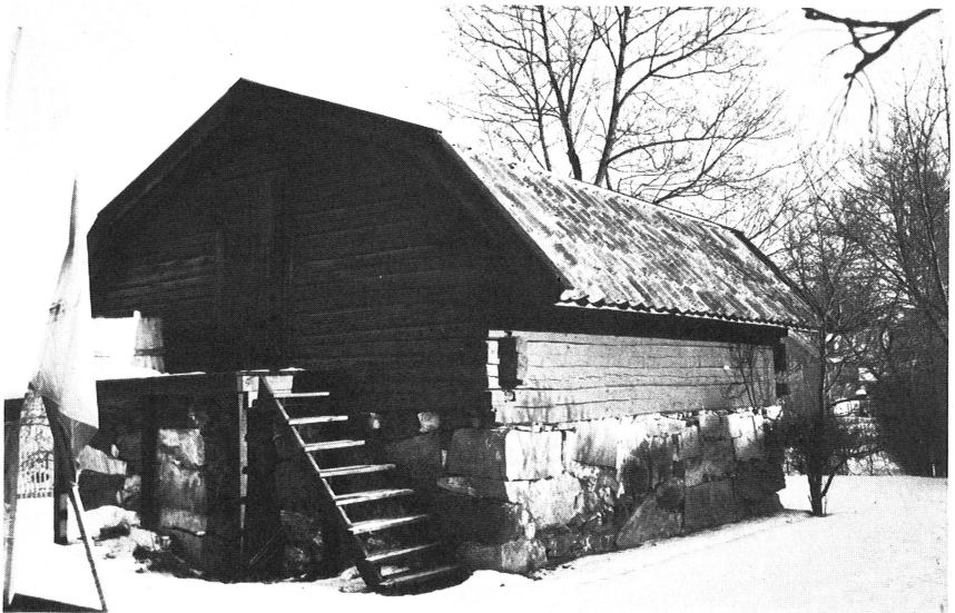
Bild 11. Östhammar. Timmerbod på hög stensockel. Många hävdar att boden överlevde ryssbranden 1719, vilket ev. kan vara riktigt. Bodan är i alla fall ett av stadens äldre hus efter kyrkan (kv. Hattmakaren 31:3).
