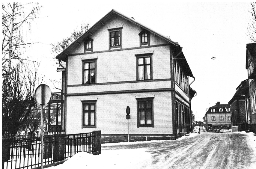
Bild 8. Östhammar. Ett klassiskt köpmanshus från 1905 – den s. k. Schramska gården som med enkelt rena linjer och fast rums- och fönsterindelning representativt visar en handelsfamiljs bostad (kv. 37:4). På gårdsplanen finns en stor färgeribyggnad i timmer från 1800-talets mitt.
