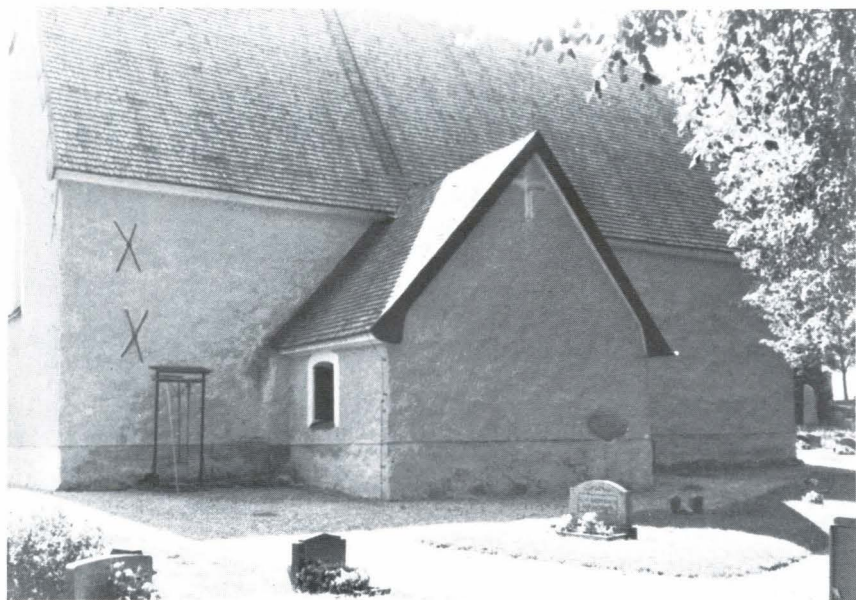
Bild 9. Hammarby kyrka. Nordväggen med sakristian. Väggen är enligt medeltida sed fönsterlös mot norr.
