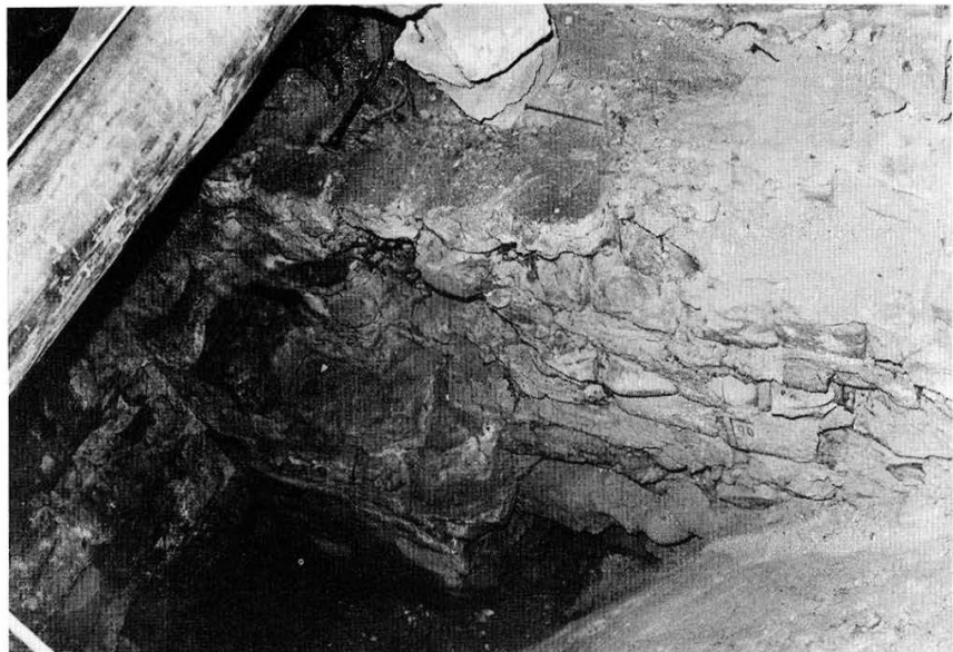
Bild 5. Långhusets östra gavelmur ansluter i söder med en stötfog mot norra sakristimurens utsida. Något väster här om det vertikala språnget i sakristimuren samt den annorlunda ytstrukturen i muren väster om språnget. Foto ATA.
