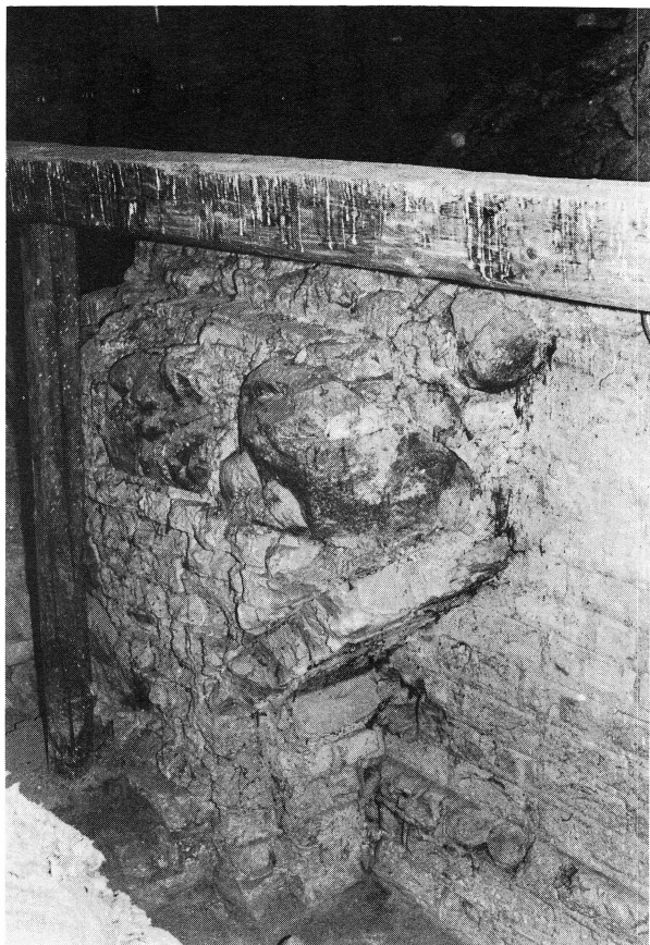
Bild 4. Södra långhusmuren fortsätter över västra sakristimurens krön i en numera avbruten avlastningsbåge av tegel som vilar mot norra sakristimurens insida. Foto ATA.
