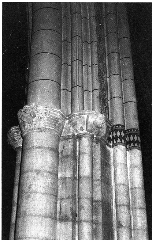
Pelare sedd från korets norra sidoskepp. I normala gotiska konstruktioner utgår sidoskeppsvalven från arkadbågarnas kapitälzon, men här sker det först från en egen kapitälzon högre upp (vid övre bildraden). – Foto Upplandsmuseets bildarkiv.
