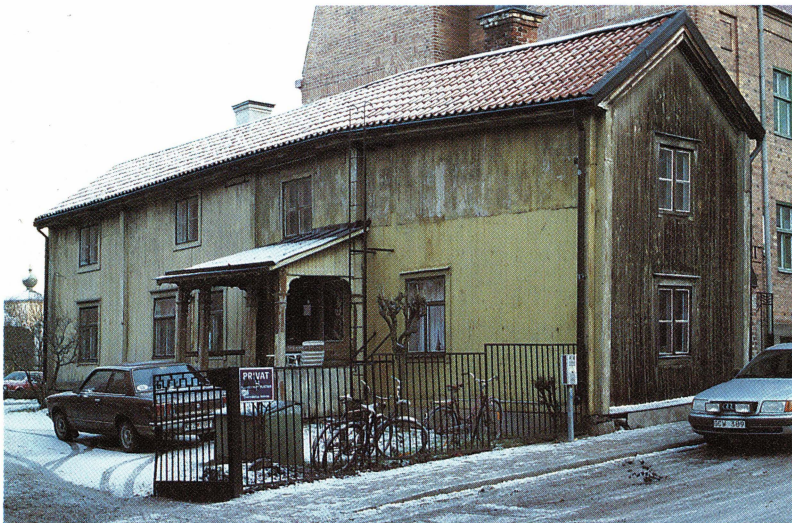
Vy från väster; i förgrunden Rundelsgränd, i bakgrunden trevåningshuset från 1912. Verandataket och väggen till höger om verandan vittnar om den tillbyggnad som revs 1953. Foto Anders Franzén.
