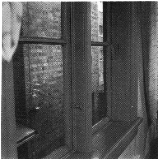
Närbild av ett fönster i salen en trappa upp. De flesta fönstren i övervåningen är från 1750-90-talen. Profilerna på spröjs, mittpost och karm är typiska för tiden, liksom de handsmidda fönsterhakarna med puckel. Flera av de ursprungliga, grönnaktiga munblåsta glastrutorna är bevarade. Foto: Anders Franzén.
