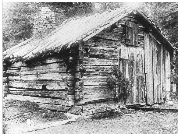
Nävern hålls på plats med stänger, s k färgtak. Smedja, Hållen, Hållnäs socken.
