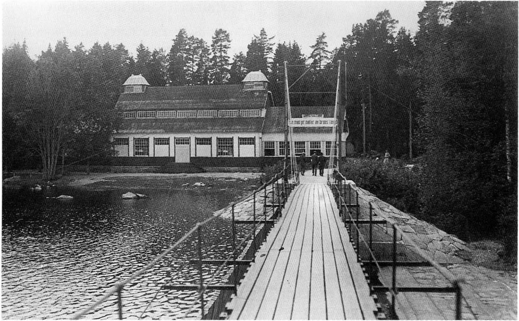
Stora Hallen och hängbron över Kungsådran. Foto omkr 1920.
