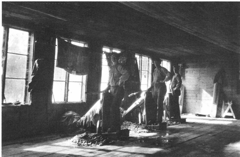
Interiör från sämsk- makeriet i Ensta. Skin- nens köttside jämnas på skavbommarna med skavknivar.
