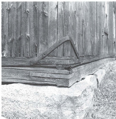
Sämskfabriken. Detalj av hörn med vinkelformat järnbeslag på grundsten.
