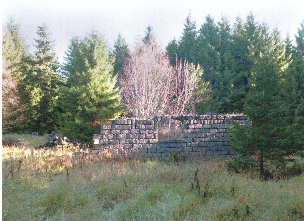
Den pampiga ladugårdsgrunden i slaggsten hör till den gamla gården Torsvall. Gården byggdes upp här i mitten på 1800-talet efter att ha flyttas ut vid laga skiftet. Det finns ytterligare minst två övergivna gårdar i det här området och flera torp. Redan i början på 1900-talet tycks Torsvall ha övergivits. På platsen finns grunder efter alla de byggnader som hörde gården till. Objekt 1005 i Tierps socken Foto Olle Norling, Upplandsmuseet.
