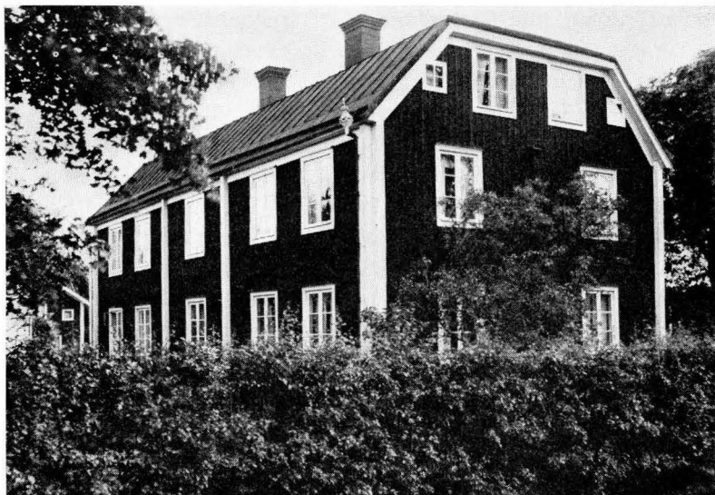
Bild 14. Manbyggnad av Arnebotyp på Röcklinge n:o 1:17, färdigställd 1845 enligt årtal på vinden.
