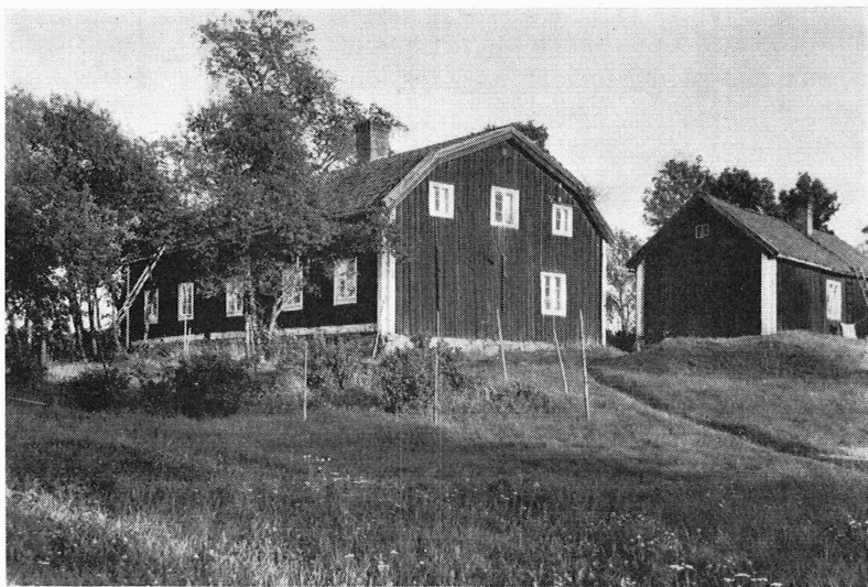
Bild 8. Manbyggnaden på Sör Starfors n:o 2: 30.
